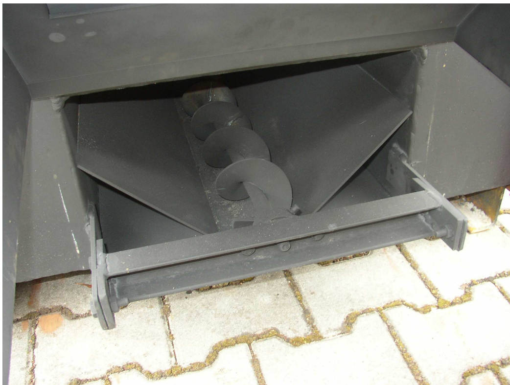
Obrázek č. 4 Automatické vyhrabovací zařízení popele u kotle o výkonu 100 kW
