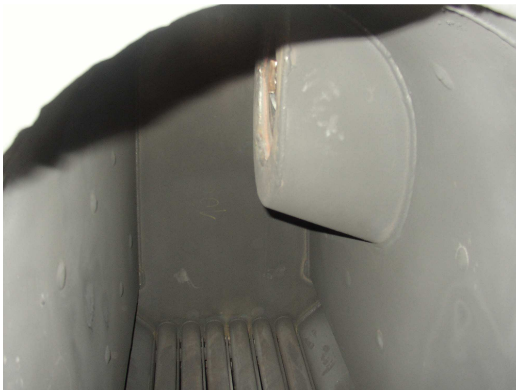
Obrázek č. 2 Čelní pohled na automatický kotel se zásobníkem o výkonu 100 kW pro ekologické spalování biomasy
