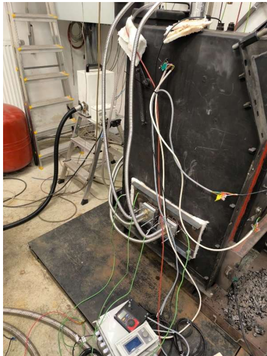
Obr. 1 Prototypový kotel osazený TEG moduly se zapojením chlazení topnou vodu
